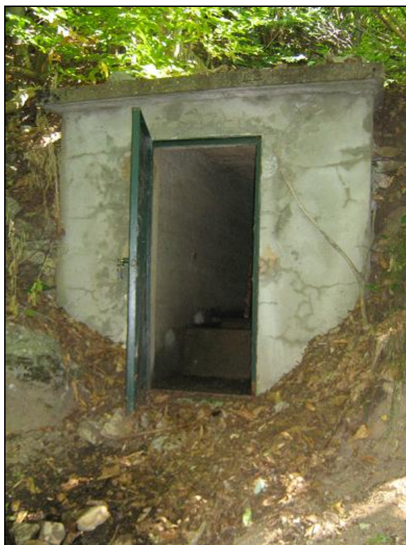
Figure 9 – Edifice protégeant le captage de Fontalard
